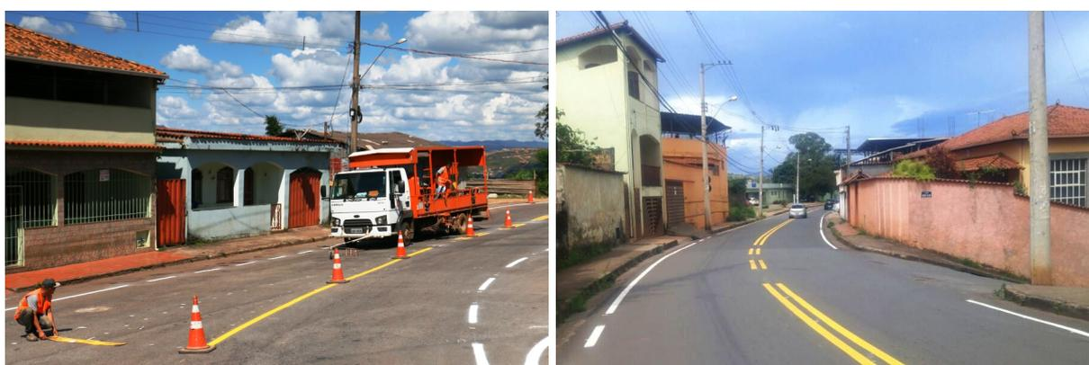
Foram pintadas passagens de pedestres, alça delimitadora de ponto de ônibus e redutores de velocidade. Também foram feitas marcas de canalização para orientar o tráfego, com áreas de estacionamento, faixas zebreadas, setas direcionais, linhas de bordo e eixo e estão sendo instalados tachas e tachões (olho de gato).
