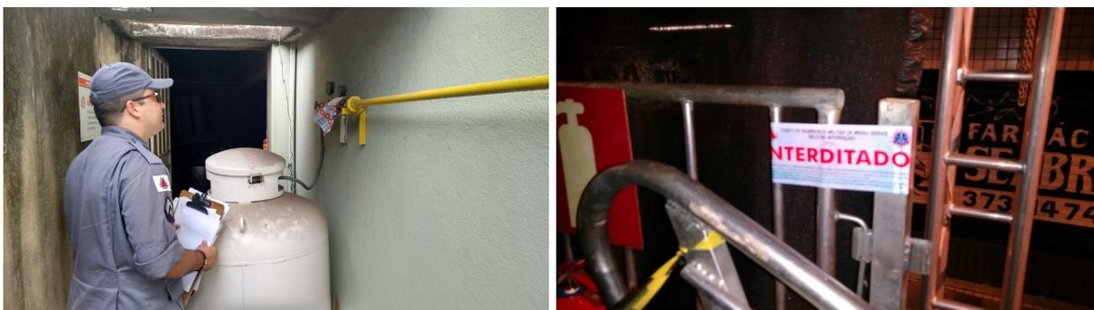
De acordo com os militares, nestas vistorias eles deparamos com a central de gás de cozinha (GLP) em ambiente confinado com risco de explosão, falta de meios preventivos como: extintores, sinalização de emergência, iluminação de emergência, saídas de emergências inadequadas e obstruídas e instalação elétrica.
